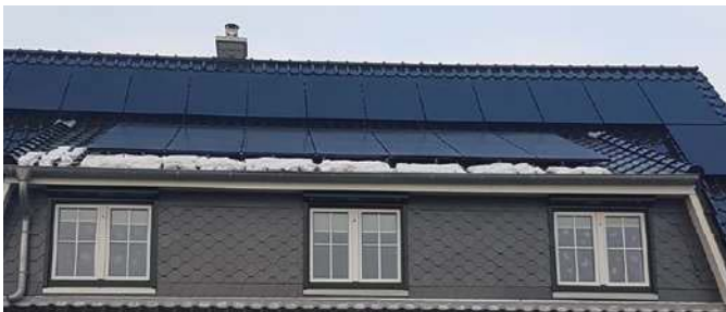
Trapezgaube geschiefert mit 3 Fenstern
