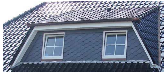
Trapezgaube geschiefert mit 2 Fenstern
