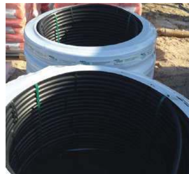
Erdwärme Rohre
