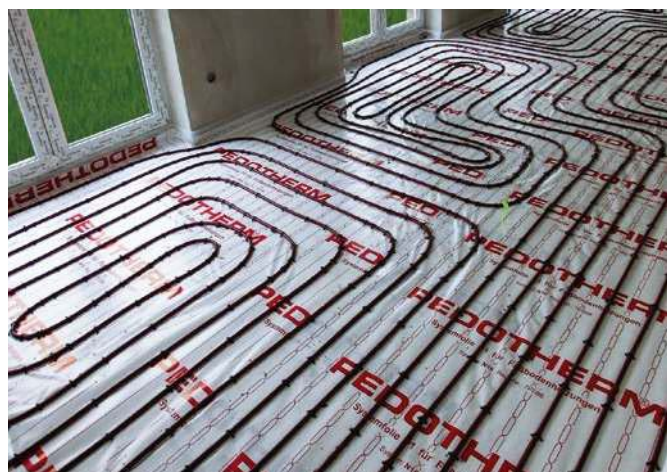
Fußbodenheizung
