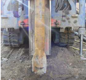
Ansicht Bohrgerät mit Bohrmeißel
