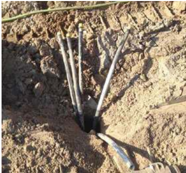
Erdwärmebohrung mit Leitungen
