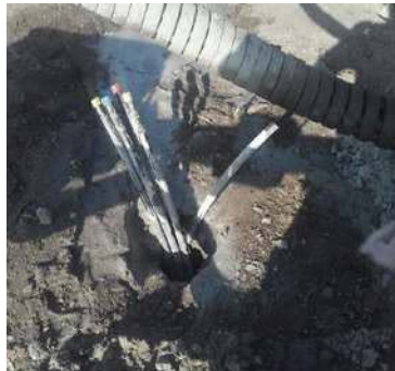
Verpresste Erdwärmeleitung
