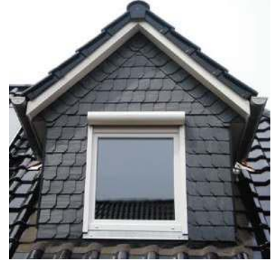
Satteldachgaube mit Rollladen
