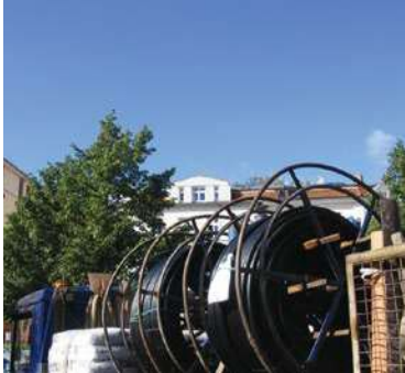
Erdsonden auf der Spindel
