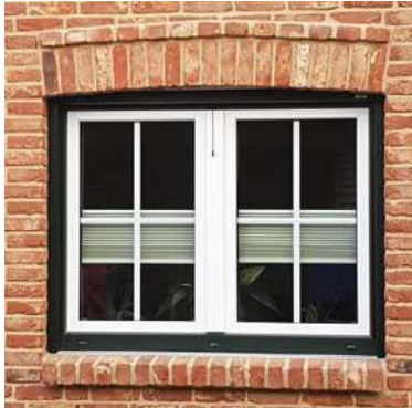
Sturz als Segmentbogen mit Augenbraue
